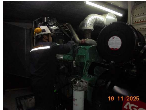
เจ้าหน้าที่ทำการตรวจสอบเครื่องกำเนิดไฟฟ้าสำรอง
