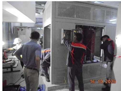
เจ้าหน้าที่ทำการตรวจสอบหม้อแปลงไฟฟ้า
