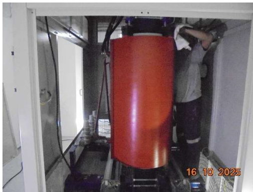
เจ้าหน้าที่ทำการตรวจสอบหม้อแปลงไฟฟ้า
